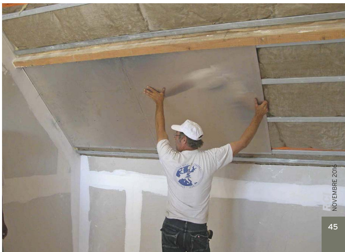
Fig. 6 - Installazione a soffitto di pannelli in cartongesso contenenti PCM (Du Pont).
